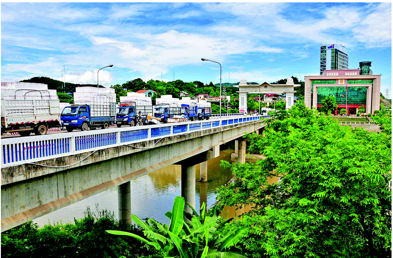
สะพานข้ามเขตแดนจีน-เวียดนาม ๑ ด่านเหอไซ่ 中越大桥
