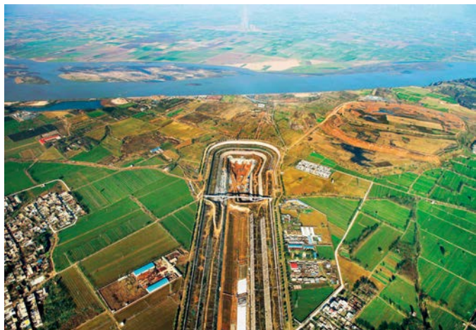
រូបថតជាប់កសារអំពីការអនុវត្តការសាងសង់នៅត្រើយខាងត្បូងនៃស្វីស្វកម្មប្រឡាយមេឡង់ទន្លេលឿងនៃគម្រោង បង្ហូរទឹកពីភាគខាងត្បូងទៅខាងជើង 南水北调中线总干渠穿黄（黄河）工程南岸施工资料照片 新华社图
