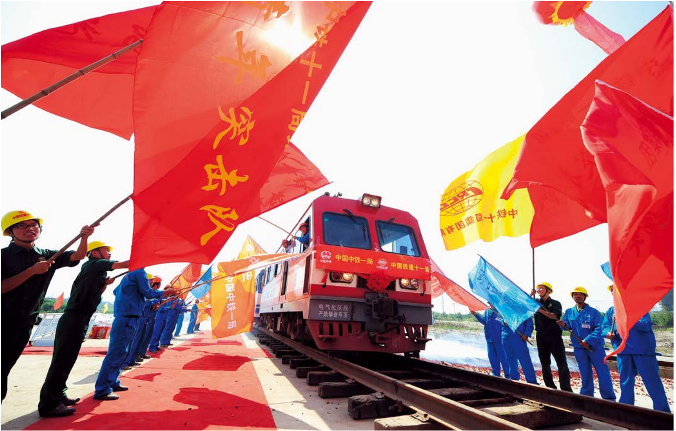
រថភ្លើងចេញពីផ្លូវក្រោមពីកំណាត់ស៊ីស្យែននៃផ្លូវថ្នល់ថ្មីក្រោមពីលេខ ១ របស់ក្រុងស៊ីអាន កម្មករសាងសង់ត្រូវទង់អបអរសាទរ 轨道车驶出西安地铁一号线西咸车辆段隧道出口，施工人员挥旗庆祝 新华社 图
