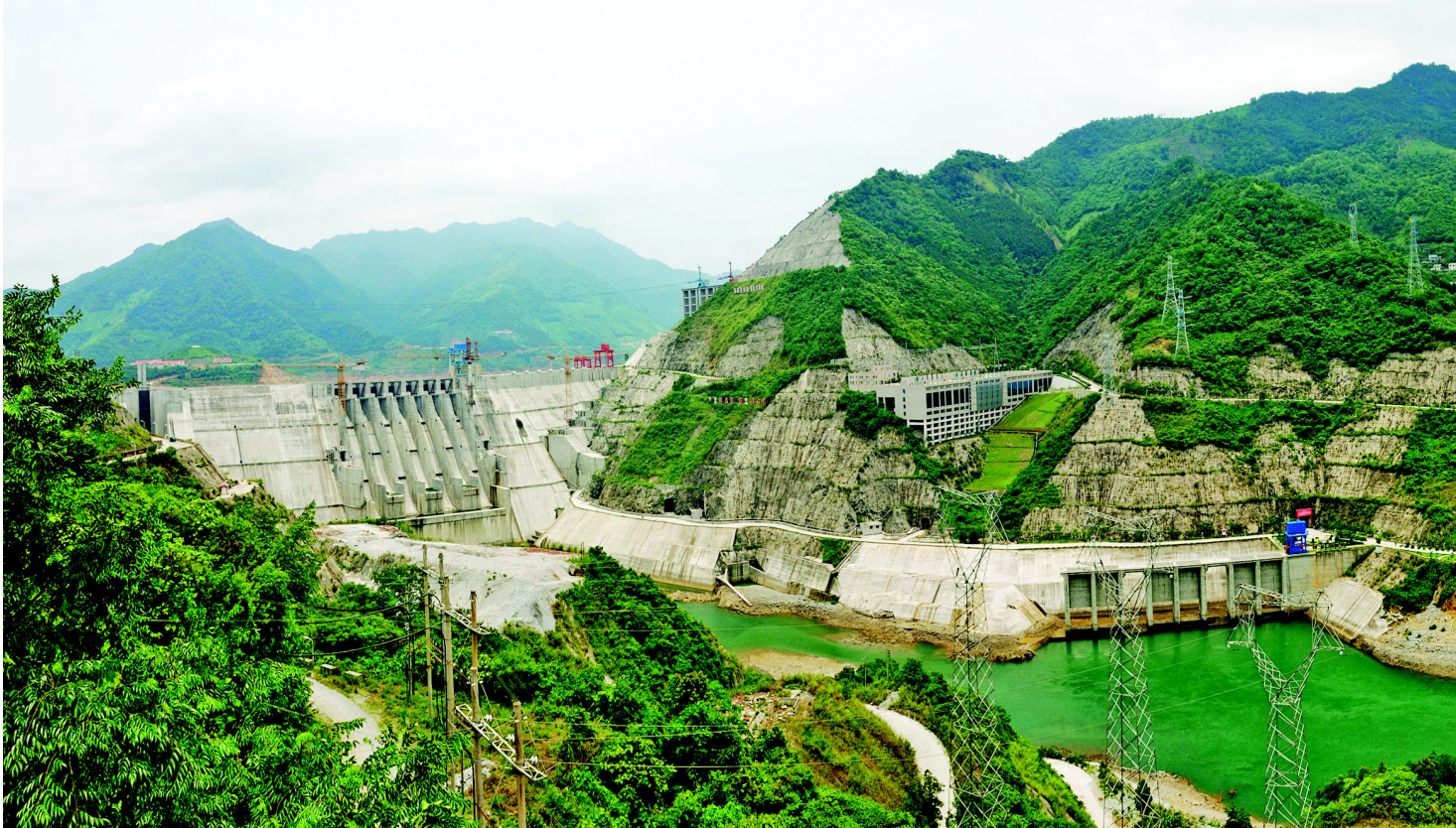
สถานีไฟฟ้าพลังน้ำหลงทานของเขตฯ กว่างซี 广西龙滩水电站
