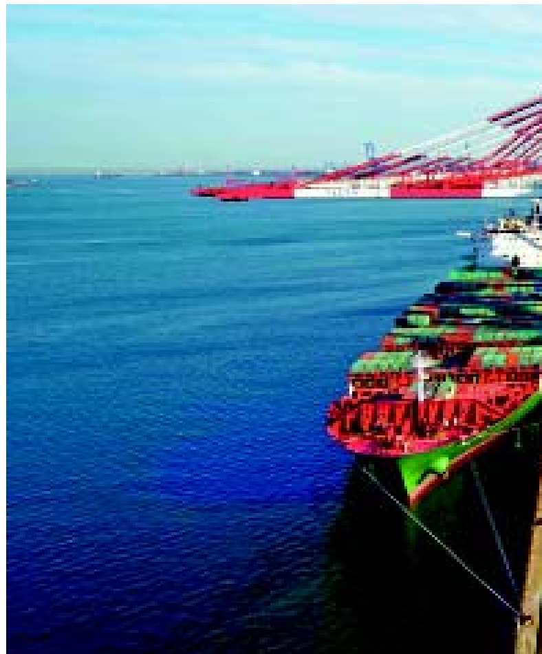
การขนถ่ายวัสดุตู้คอนเทนเนอร์ในท่าเทียบตู้คอนเทนเนอร์ของท่าเรือเทียนจิน 天津港联盟国际集装箱码头进行集装箱装卸作业
