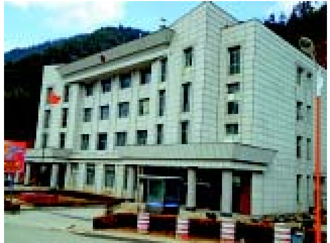
อาคารตรวจคนเข้าออกด่านของด่านพรมแดนเพื่อนหม่า 片马口岸联检大楼
