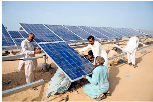
ໂຄງການ 900 mw ແລວທາງເສດຖະກິດລະຫວ່າງຈີນ-ປາກີສະຖານ 中巴经济走廊 900 兆瓦光伏项目
