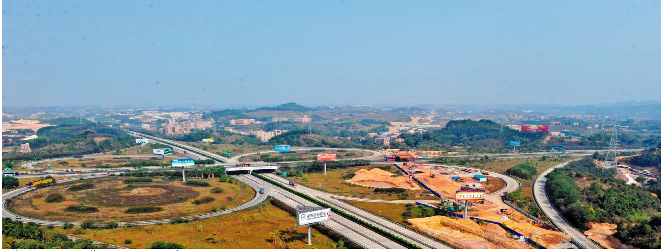
ການກໍ່ສ້າງ“ຊ່ອງທາງນານນິນ-ສິງກາໂປ” ໄດ້ສ້າງບົດໃໝ່ແຫ່ງການພັດທະນາເອດການຄ້າເສລີຈີນ-ອາຊຽນ “南新通道” 建设勾勒中国 - 东盟自贸区发展新篇章
