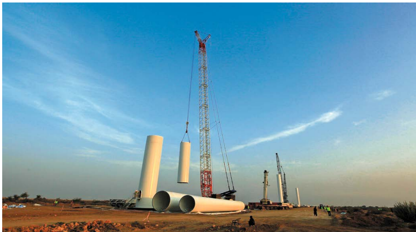
ການກໍ່ສ້າງ ແລວທາງເສດຖະກິດຈີນ-ປາກີສະຖານ ຍູ່ແຮງການພັດທະນາໄຟຟ້າຂອງປາກີສະຖານ “中巴经济走廊” 建设助力巴基斯坦电力发展
