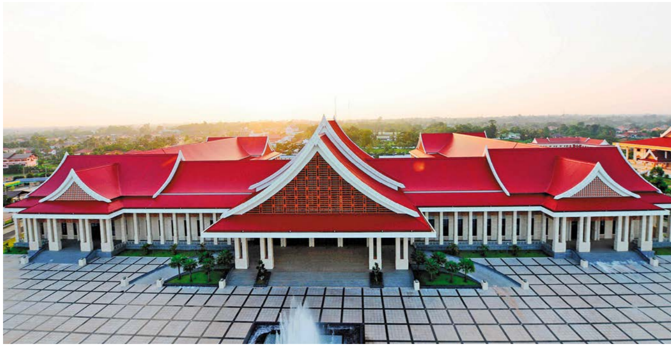
ຫໍປະຊຸມແຫ່ງຊາດລາວເຊິ່ງແມ່ນບໍລິສັດຫຸ້ນສ່ວນກໍ່ສ້າງຈີນຈຳກັດເປັນຜູ້ຮັບເໝົາກໍ່ສ້າງ 由中国建筑股份有限公司承建的老挝国家会议中心
