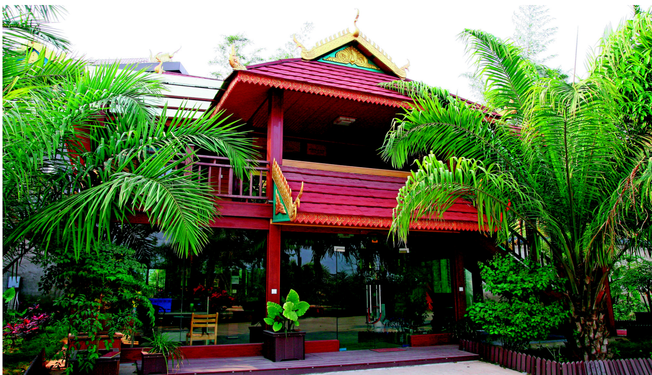
บ้านเรือนก่อสร้างด้วยไม้พลาสติกที่แปรรูปจากเมล็ดยางพารา 用橡胶籽加工成木塑建造的民居 半清图
