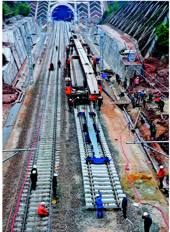
ทางรถไฟแพนเอเชียสายตะวันตกช่วงกว้างทาง-คุนหมิงที่เป็นรางคู่ได้วางรางเสร็จเรียบร้อย และเชื่อมต่อกันอย่างราบรื่น 泛亚铁路西线广(通)昆(明)铁路复线全线铺轨完工，顺利实现合龙 新华社图
