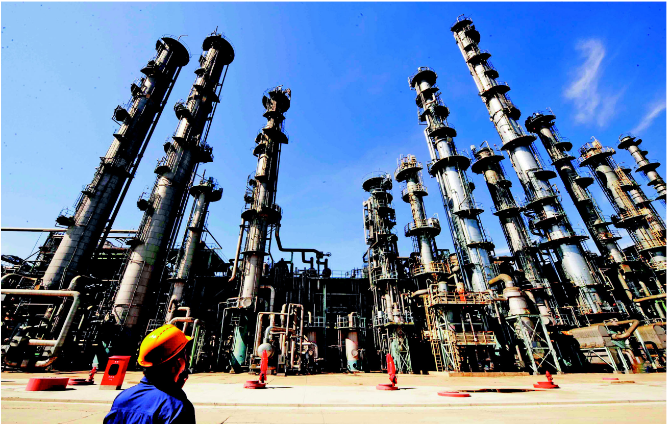
คนงานกำลังตรวจสอบอุปกรณ์ผลิตเอทิลีน 600,000 ตัน 工人在检查 60 万吨乙烯生产装置
