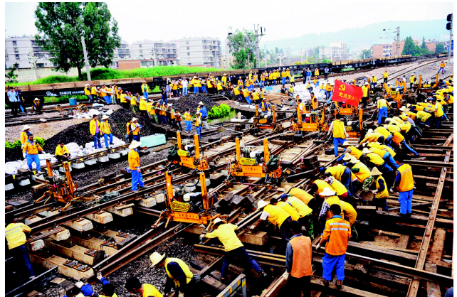
ทางรถไฟขนส่งสินค้ามณฑลยูนนานกำลังเปลี่ยนประเภท (รถไฟ) เพื่อแยกกำลังขนส่งให้สูงขึ้น 云南货运铁路更换道岔以提高运力
