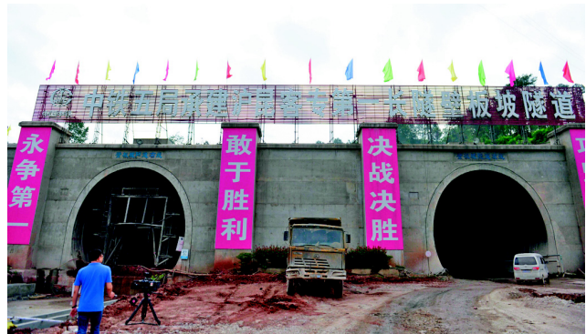
อุโมงค์บ่บั้นพั่วซ่งยาว “อันดับแรก” บนทางรถไฟความเร็วสูงสายเซี่ยงไฮ้-คุนหมิง ได้ขุดเจาะตลอดสายได้สำเร็จ 沪昆高铁“第一长隧”壁板坡隧道全线贯通
