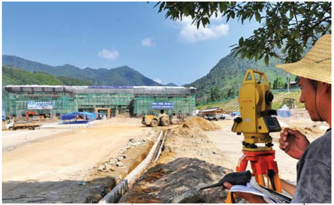
ໂຄງການວິສະວະກຳຫຼັກຖືກອາຄານຮ່ວມສຳພັນກວດກາດ່ານເຕີຊຽວເທິງຊິງຢູນນານໄດ້ສຳເລັດຜົນ ຍຸນນານ (腾冲猴桥口岸联检大楼主体工程竣工 新华社图
