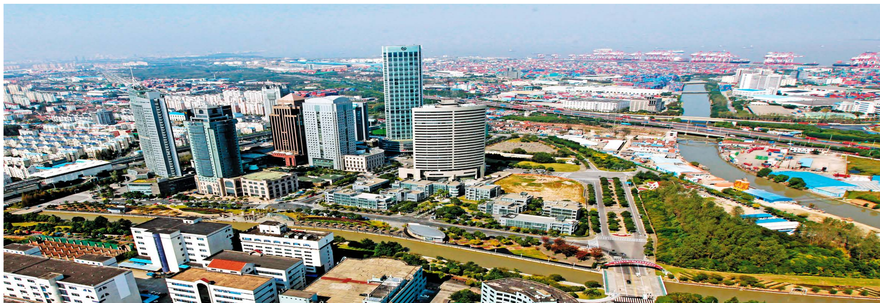
ພາບລວມເຂດປອດພາສີກາວຊຽວເຂດນອກນະຄອນຊຽງໄຮ 上海市外高桥保税区全景
