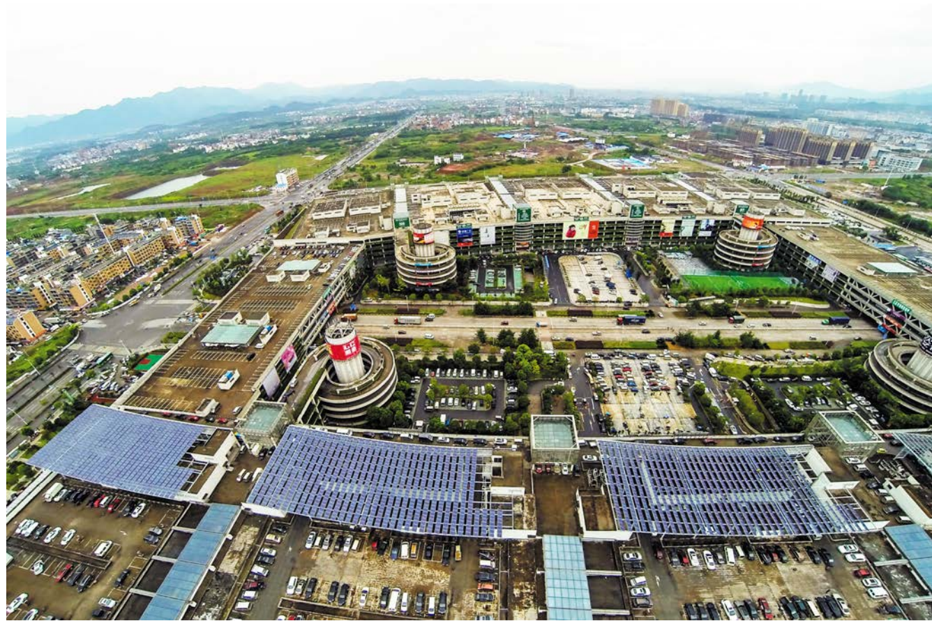
ລະບົບກຳເນີດໄຟຟ້າດ້ວຍແສງສະຫວ່າງຢູ່ອາຄານເຂດ 4 ຕະຫລາດການຄ້າສາກົນຮີອູ 义乌国际商贸城四区楼顶光伏发电系统
