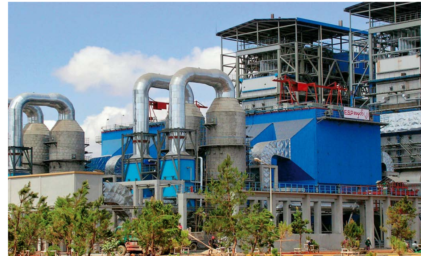
မြန်မာနိုင်ငံလျှပ်စစ်ဓာတ်အားပေးစက်ရုံမှအသုံးပြုလျက်ရှိသောရွှေမိဟွာသတ္တုကျွန်းပတ်ဝန်းကျင်ထိန်းသိမ်းရေးစက်ပစ္စည်းထုတ်လုပ်ရေး(တပ်ဆင်ရေး)ကုမ္ပဏီလီမိတက်မှ ထုတ်လုပ်သော စတုရန်းမီတာ ၁၅၀ လျှပ်စစ် dust catcher 缅甸国家电力公司发电厂投入使用的宣化冶金环保设备制造(安装)有限责任公司产 150 平米电除尘器 新华社图
