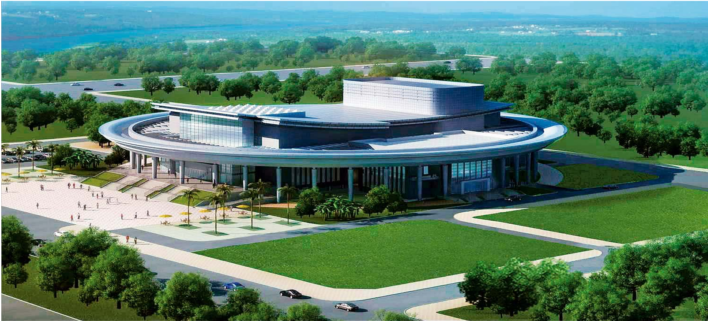
အကူအညီဖြင့် တည်ဆောက်ထားသော ဗီယက်နမ်တရုတ်ချစ်ကြည်ရေး အဆောက်အအုံကို အပေါ်စီးမှ မြင်တွေ့ရပုံ။ 援建越南越中友谊宫项目鸟瞰图
