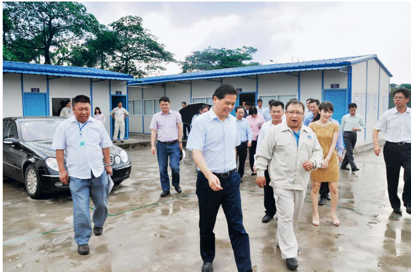
ပြည်နယ်အုပ်ချုပ်ရေးမှူး၊ ချိန်ဟောင်က ယူနန်ဆောက်လုပ်ရေးအဖွဲ့မှ တာဝန်ယူအကောင်အထည်ဖော်ခဲ့သော ဗီယက်နမ်-တရုတ်ချစ်ကြည်ရေးမိမိမာန်စီမံကိန်းတွင်လှည့်လည်ကြည့်ရှုစဉ်။ 陈豪省长视察云南建工集团承建的援建越南越中友谊宫项目
