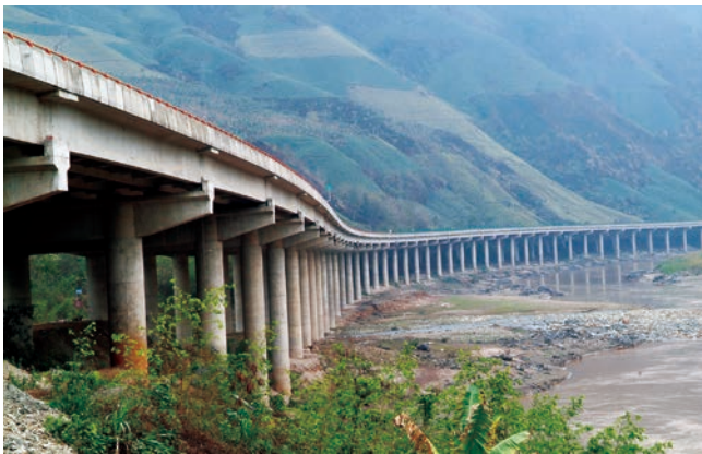
ທາງດ່ວນຈາກຊົນກາຍເມືອງເຕີເຄີຢູນນາມເຖິງແຂວງລາວກາຍຫວຽດນາມໄດ້ໂລ່ງຫາກັນທົ່ວ ທັງສາຍແລ້ວ 云南河口县新街连接越南老街省的高速公路全线贯通 新华社 图
