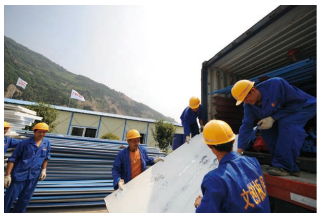
ບັນດາກຳມະກອນຍົກຖ່າຍວັດສະດຸກໍ່ສ້າງທີ່ປະກອບເປັນເຮືອນແປ້ນໄມ້ຕາແສງອິນຊຽວເວີນຊວນ 工人们在汶川映秀镇搬运活动板房的组材料 新华社图
