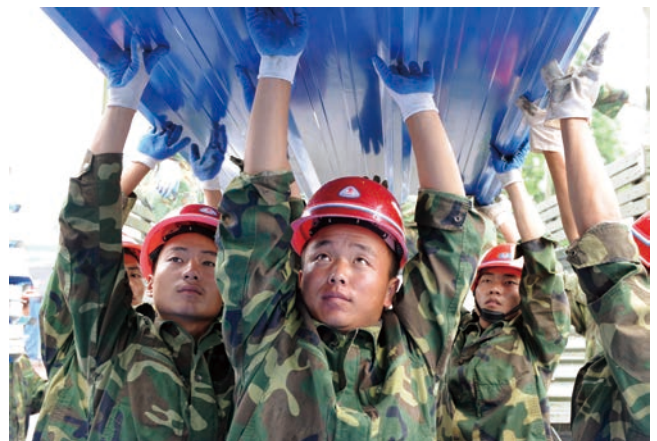
ນັກຮົບພວນຍົກຖ່າຍແຜ່ນເຫຼັກສີສາມາດເຄື່ອນທີ່ໄດ້ຢູ່ຈຸດຕາແສງປັນແຊວນະຄອນມຽນຈູ 战士在绵竹市板桥镇安置点卸活动板房彩钢瓦 新华社图
