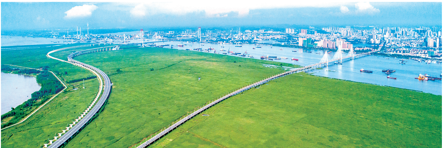
ນະຄອນຍິ່ວຢ່າງສ້າງຊາຍຝັ່ງແມ່ນ້ຳຢ່າງເຊກງຽງທີ່ສວຍງາມທີ່ສຸດ, “ທາງເດີນເຮືອຄຳ” ຕາມແມ່ນ້ຳຢ່າງເຊກງຽງທີ່ຍາວ 163 ກິໂລແມັດໄດ້ເປັນມິດຕິສິ່ງແວດລ້ອມນິເວດທີ່ສຸດ.
