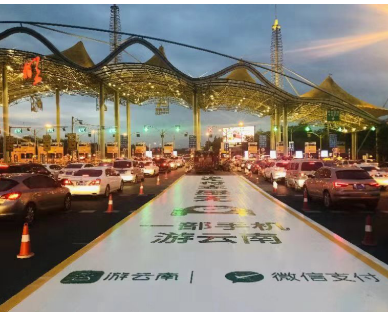
Jalur Tol Propinsi Yunnan Mengaktifkan Percobaan "Pembayaran Tanpa Kontak"
