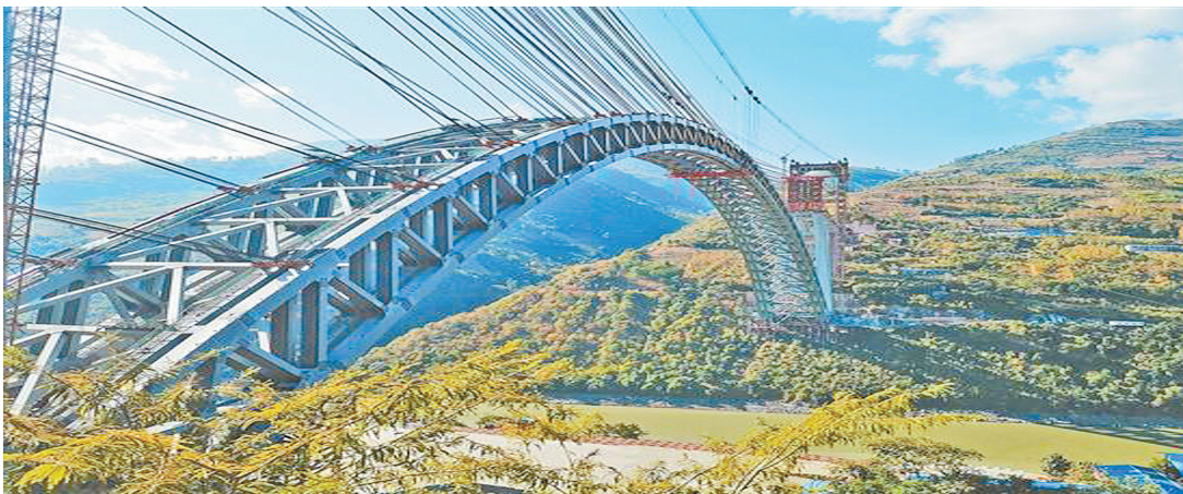
12月10日，大理至瑞麗鐵路全綫重點控制性工程——怒江四綫特大桥按期實現鋼桁拱合龍，這是目前世界跨度最大的鐵路拱橋。
