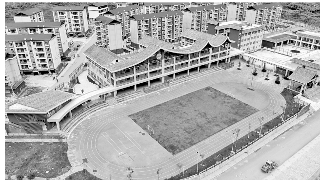
建造于怒江边的云南怒江傈僳族自治州泸水市大兴地镇维拉坝珠海社区。 新华社发
